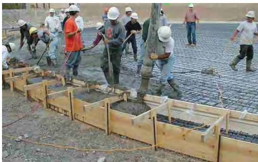
चित्र 2.14 — प्रबलित सीमेंट कंक्रीट (Reinforced Cement Concrete)
