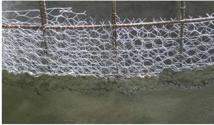
चित्र 2.23 — फेरो सीमेंट कार्य (Ferro Cement Work)
