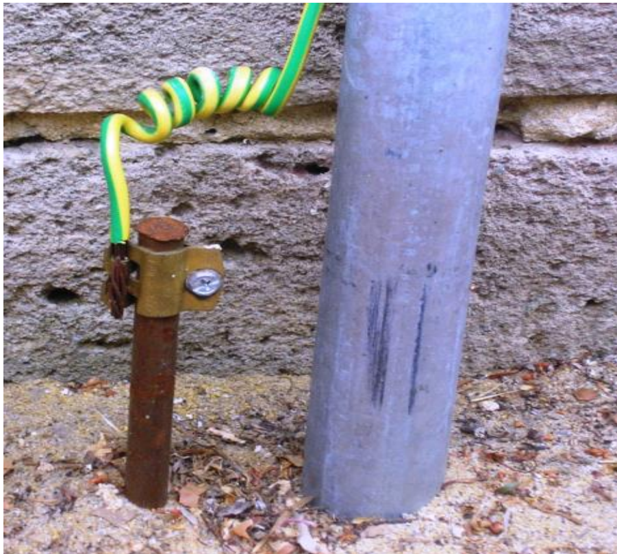
Fig. 3.44 Rod Earthing
