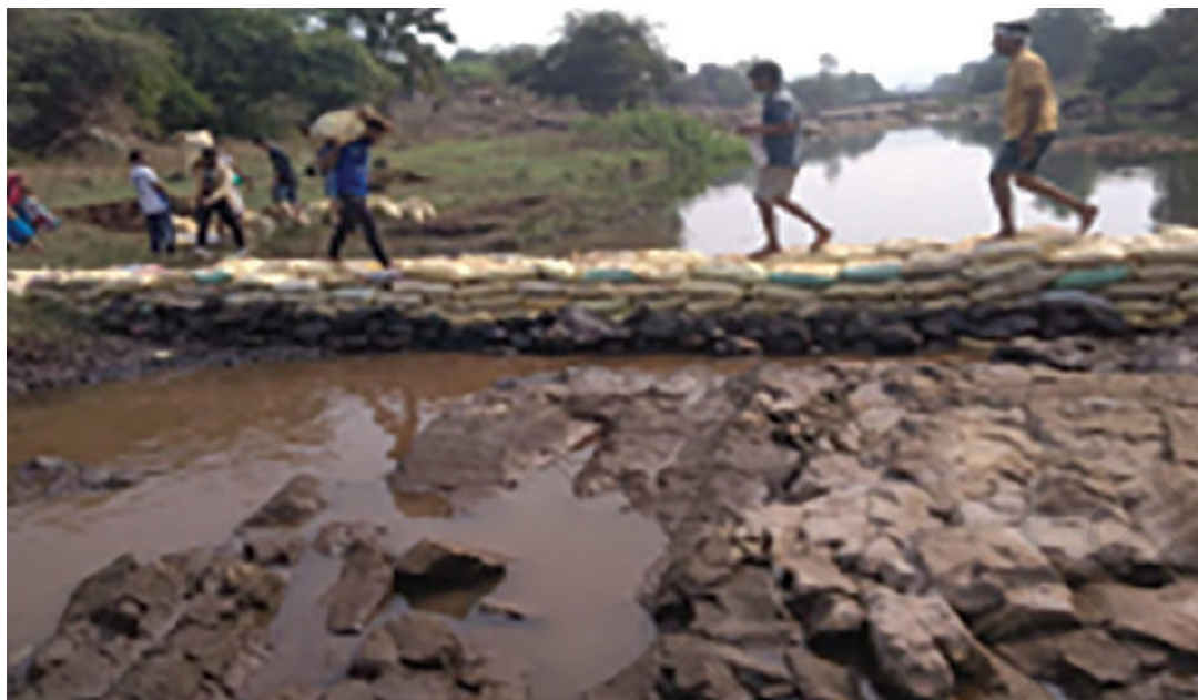
चित्र 5.12— सिंचाई के लिए उपयोग की जाने वाली जलधारा पर चेक डैम
